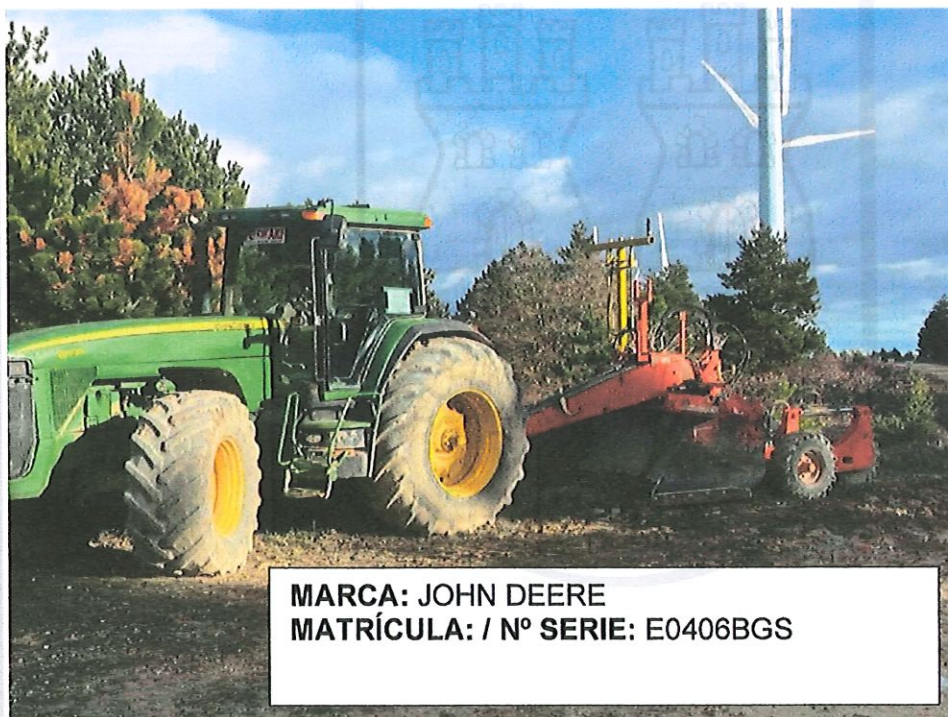
Imagen 29 (maquinaria pesada utilizada con cartelería explícitamente indicando que se utiliza en la construcción del parque eólico de Labraza)
