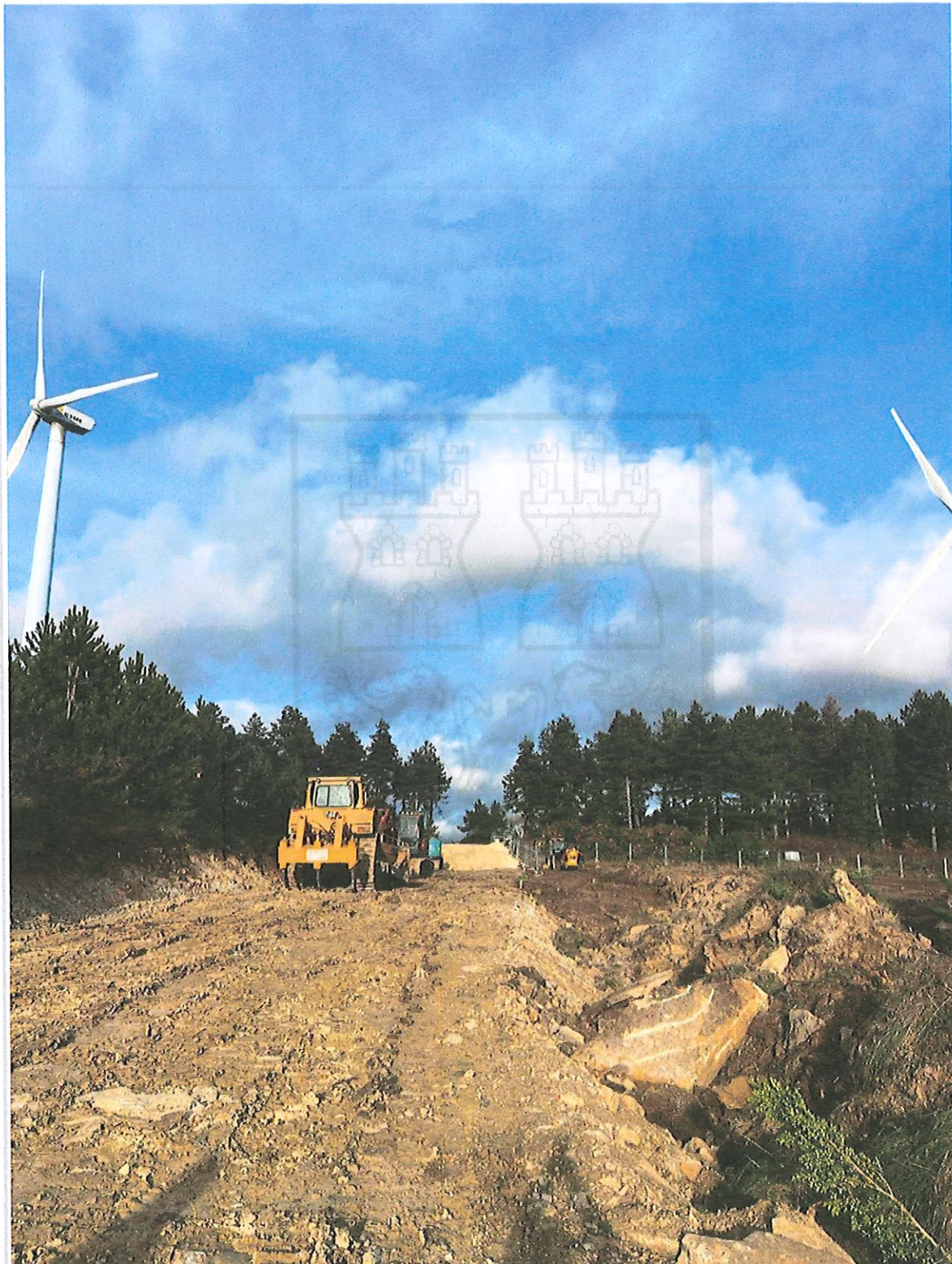
Imagen 14 (ensanchamiento y maquinaria pesada trabajando camino Matarredos límite Comunidad Foral de Navarra)
