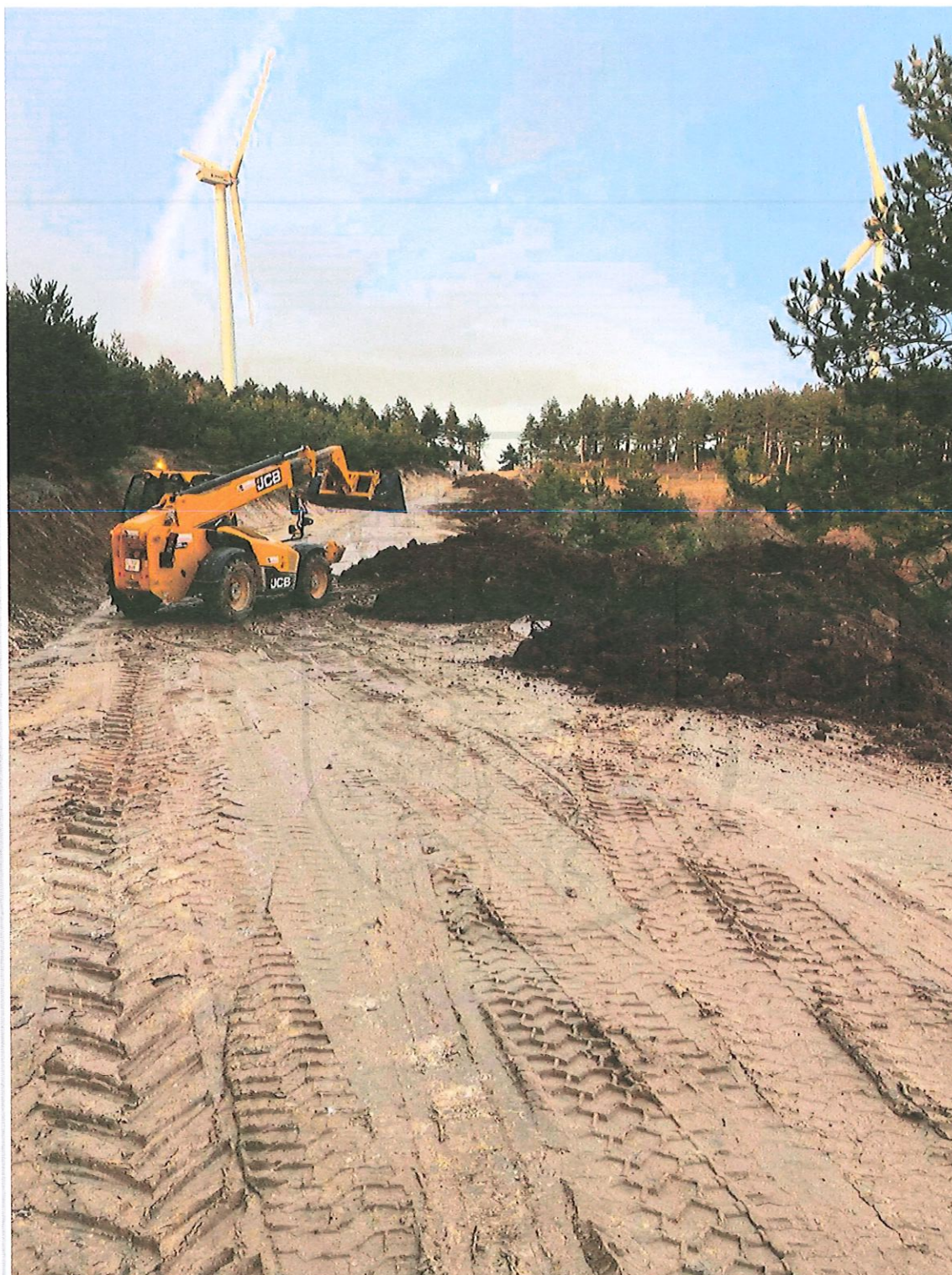
Imagen 22 (operaciones de trabajos con maquinaria pesada)
