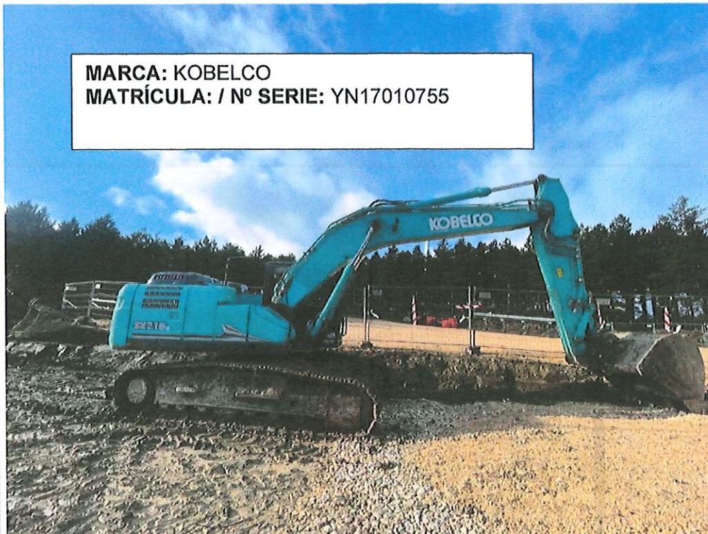
Imagen 30 (maquinaria pesada utilizada con cartelería explícitamente indicando que se utiliza en la construcción del parque eólico de Labraza)
