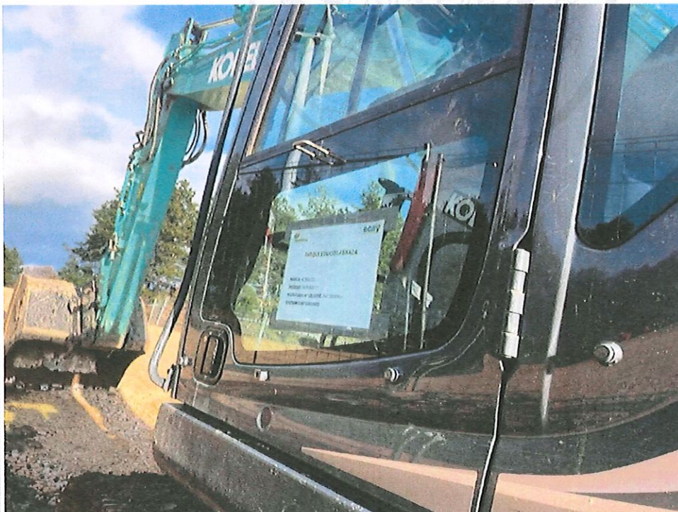
Imagen 31 (maquinaria pesada utilizada con cartelería explícitamente indicando que se utiliza en la construcción del parque eólico de Labraza)
