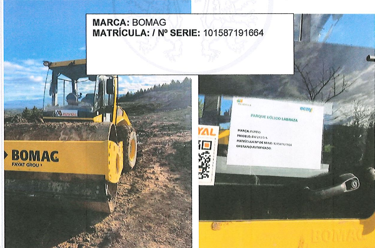
Imagen 35 (maquinaria pesada utilizada con cartelería explícitamente indicando que se utiliza en la construcción del parque eólico de Labraza)
